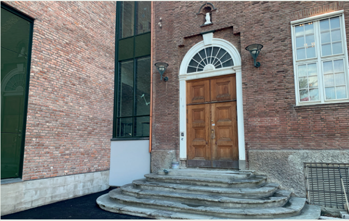
Trappa i Moebygget 1 fra 1925 ble demontert og satt opp på nytt da nybygget ble oppført.
